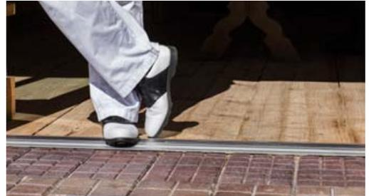
*Ein schwellenfreier Terrassenausgang dank Magnetdoppeldichtung.*
