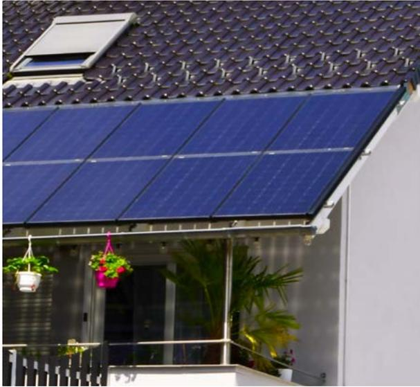
Abb. 6: Solarmodule als Balkonüberdachung ausgeführt. Hier müssen besondere Solarmodule verwendet werden.
